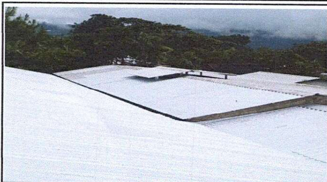
Foto 1: CUBIERTA DE LAMINAS Y ESTRUCTURA DE TECHO CORREDOR
