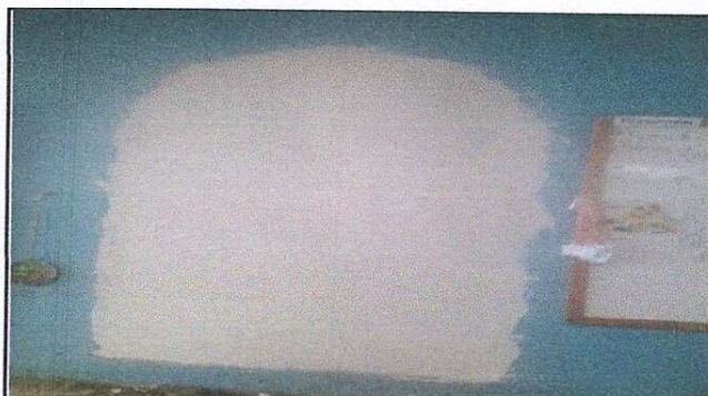
Foto 4: REPARACION DE REPELLO Y CERNIDO DE PARED ENTRE AULAS DE PRIMERO SECCION A Y PRIMERO SECCION B
