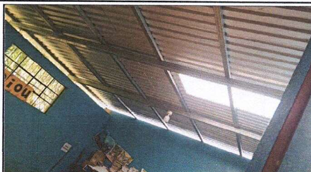
Foto 2: CUBIERTA DE LAMINAS Y ESTRUCTURA DE TECHO, AULA DE PRIMERO SECCION B
