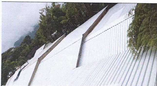
Foto 3: CUBIERTA DE LAMINAS Y ESTRUCTURA DE TECHO AULAS, SEGUNDO, TERCERO, CUARTO Y COCINA
