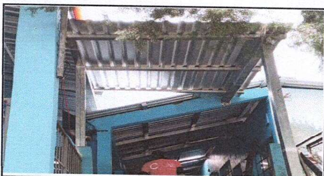
Foto 5: CUBIERTA DE LAMINAS Y ESTRUCTURA DE TECHO DE ENTREDA DE LA ESCUELA
